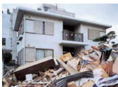
阪神・淡路大震災でガラス1枚割れなかったパルコン
